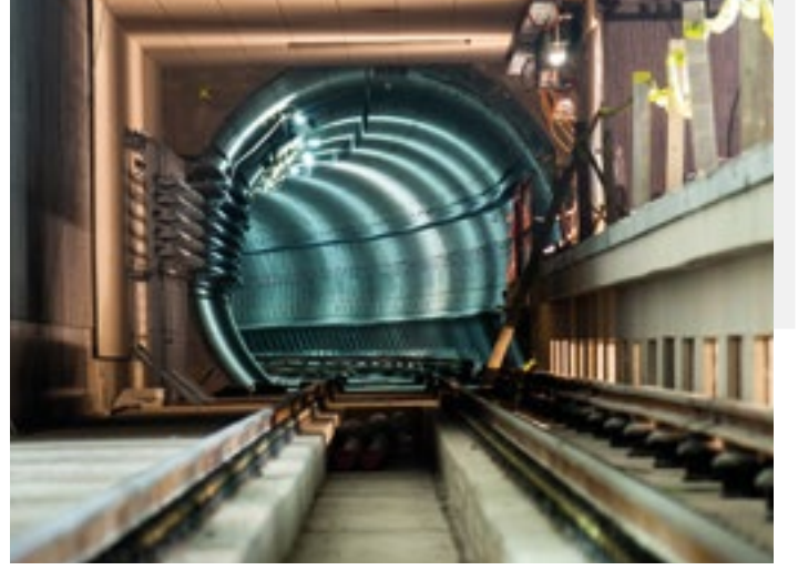
TÜNEL VE YER ALTI YAPILARI
